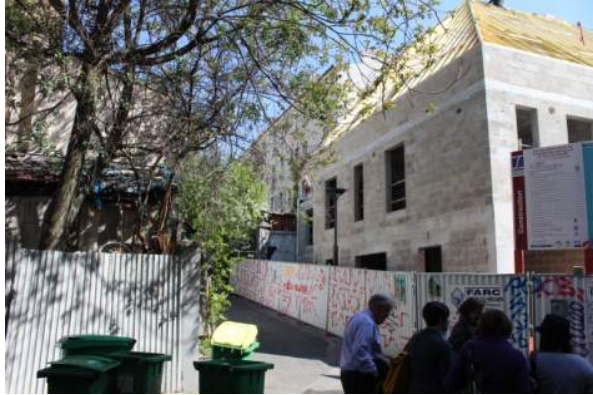
Logements sociaux en construction (en face d'un squat), rue de l'Ermitage (16 avril 2014).
