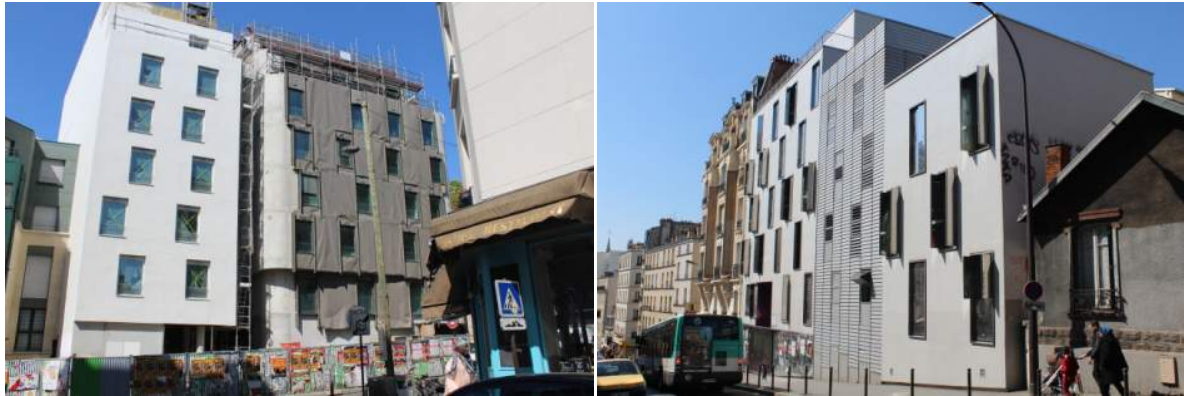
Logements sociaux en construction et résidence étudiante situés rue de Ménilmontant (16 avril 2014).
